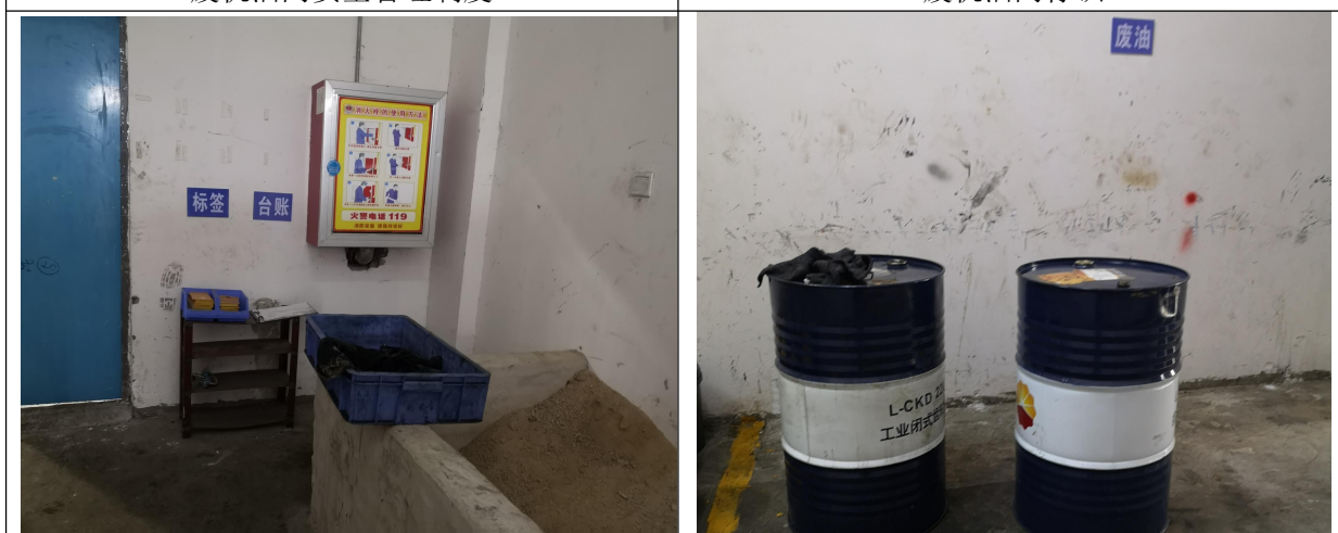
废旧机油库台账存放处及消防措施
